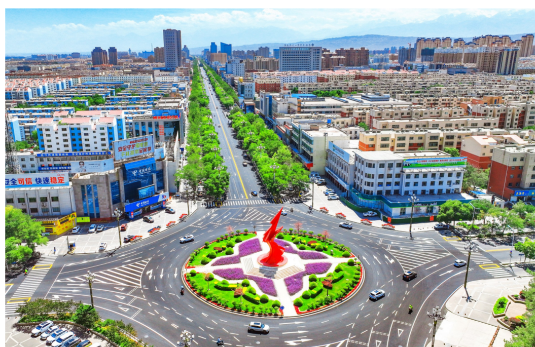
2023年，我市新华路提升改造工程完工，进一步提高道路通行能力，改善市民出行环境。
